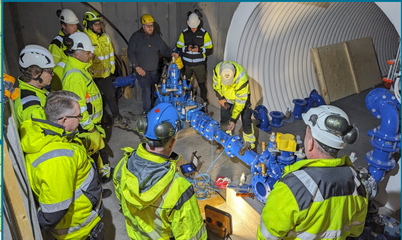
Kjeller - firkantkum m/blågods, instrumentering
