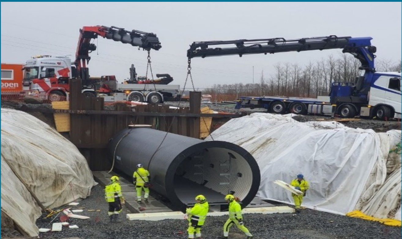
Kulvert 12 m/Ø3000 – ledninger trykk & overvann
